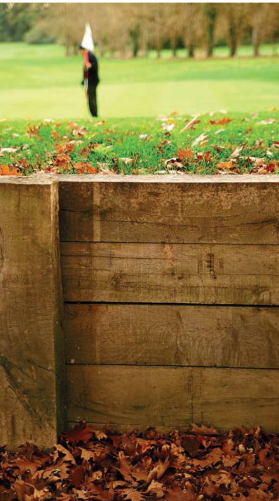
» RETENUES DE TERRE
