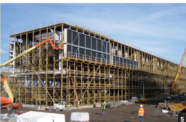
**5.** Cet impressionnant quadrillage est l'ossature d'une tour de refroidissement de centrale électrique dite « thermique ». Cet ouvrage est constitué d'éléments en pin de France, matériau à la fois structurel, léger et résistant à la corrosion.
