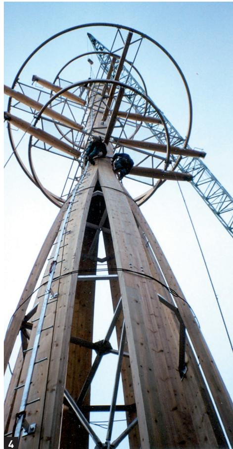
**4.** Ce pylône électrique haute tension de 31 m de hauteur est en pin lamellé-collé lasuré. Il est l'œuvre du célèbre designer Martin SZEKELY pour EDF en 1994.
